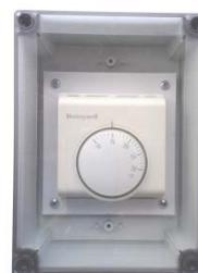
Utilisé pour une commande de compensation météorologique simple (désactive le chauffage lors des journées chaudes)
